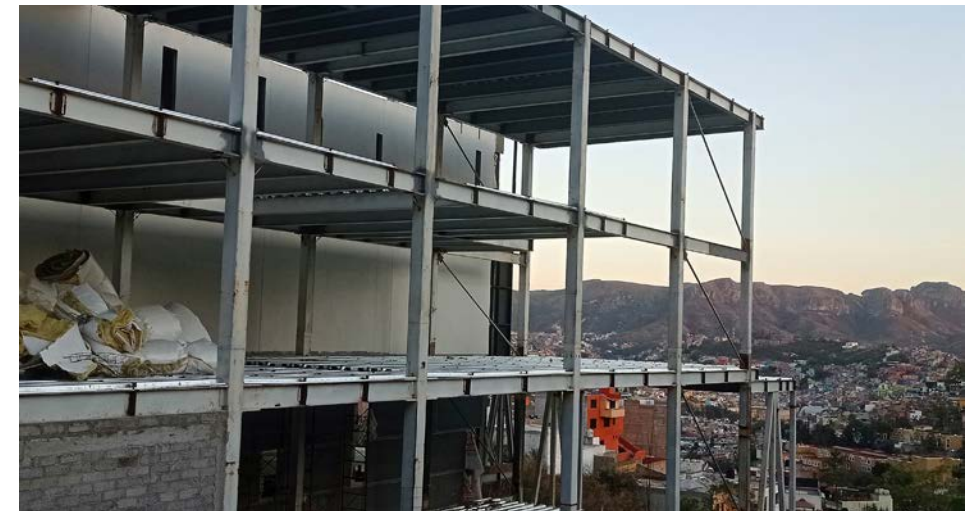
Figura 5. En una zona residencial es construida una casa de lujo cuya estructura es de cimientos de concreto y vigas de acero; las que serán paredes contendrán en su interior fibra de vidrio como aislante termoacústico. Fotografía: Sandra Ramírez.
