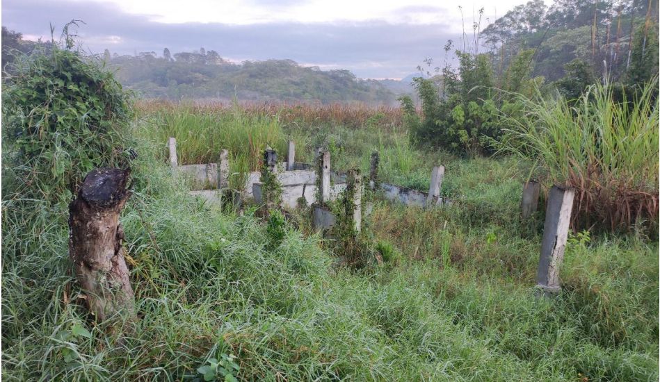
Figura 19. Edificación abandonada e invadida por la vegetación. Al pie del camino, entre pasto y enredaderas que han llegado a okuparla, se descubre una construcción en ruinas que no se levantó más allá de sus pilares, quizás como estructura para sostener una techumbre de teja o de lámina. Extrañamente, se asienta sobre una zona pantanosa inundable: ¿alguna falta de previsión o de información por parte de sus constructores?
