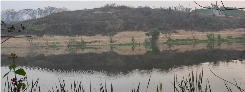
Figura 11. Trabajos de apertura de una brecha en las faldas de los cerros . Fotografía tomada en 2015 donde se pueden verificar los trabajos de apertura de la brecha alrededor de la laguna, al pie de los cerros que la circundan: rascadura, incisión, corte, incisión. La maquinaria excavó la tierra ocre de las faldas y depositaron el excedente hacia abajo.
