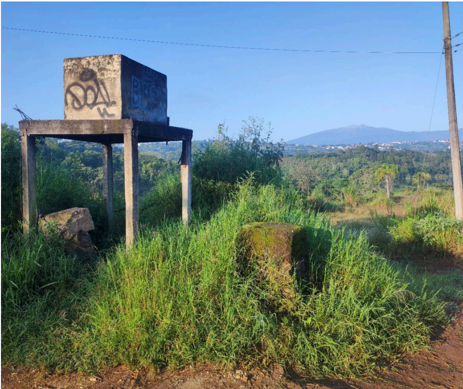
Figura 18. Tinaco elevado fuera de uso . Este tinaco de cemento es el único vestigio de una casa después de que la familia que la habitaba abandonase el lugar.
