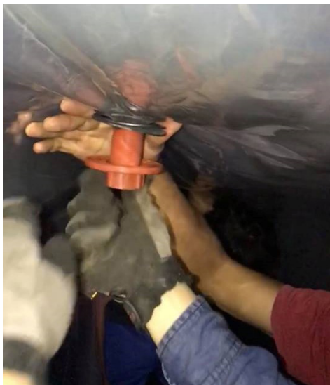
FIGURA 6. Instalación de la válvula de gas
