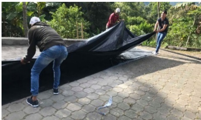
FIGURA 5. Instalación del plástico de polietileno
