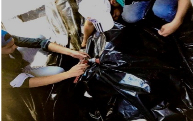
FIGURA 7. Instalación de la válvula de salida
