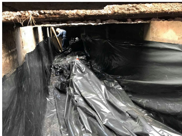
FIGURA 9. Traslado del biodigestor a la caja de acumulación
