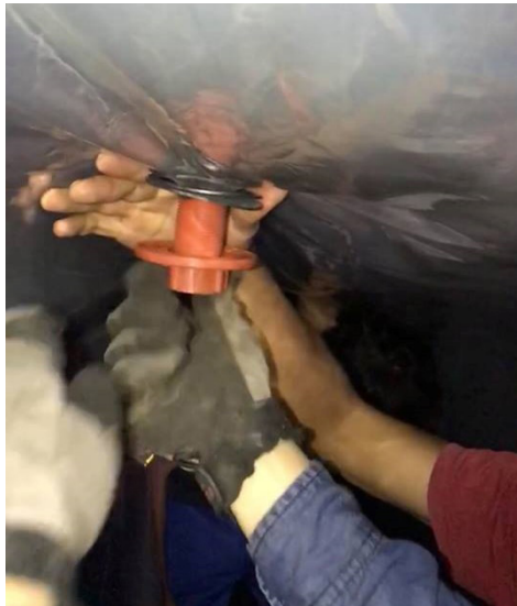
FIGURA 6. Instalación de la válvula de gas
