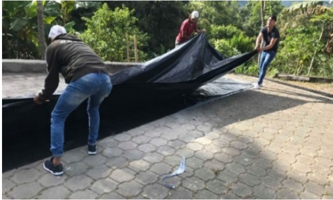
FIGURA 5. Instalación del plástico de polietileno
