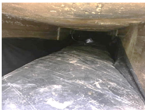
FIGURA 10. Inflado del biodigestor
