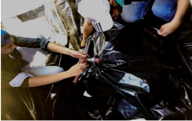
FIGURA 7. Instalación de la válvula de salida
