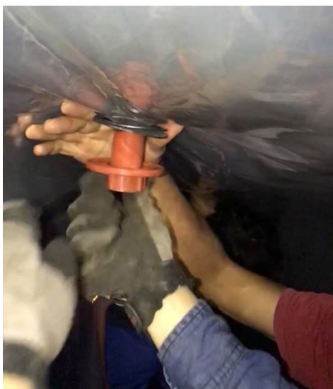
FIGURA 6. Instalación de la válvula de gas
