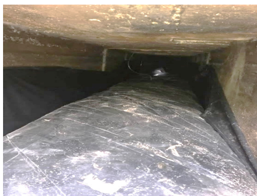
FIGURA 10. Inflado del biodigestor
