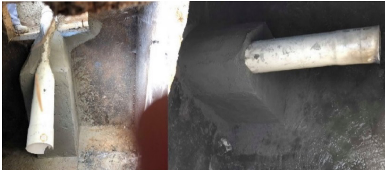
FIGURA 8. Entrada y salida de materia orgánica
