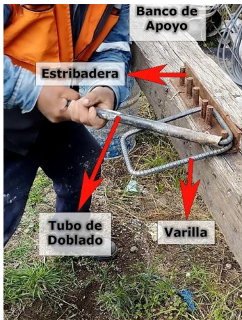
Figura 4. Práctica de doblado tradicional de varillas de acero.
