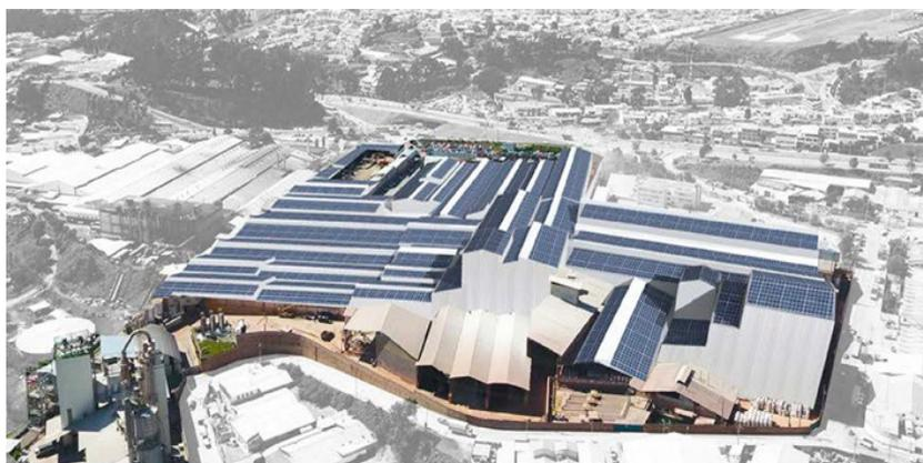
**Figura 4:** Fotomontaje de propuesta de integración de 41600 m<sup>2</sup> de captación PV en edificio industrial en Cuenca, Ecuador (los autores [48])
