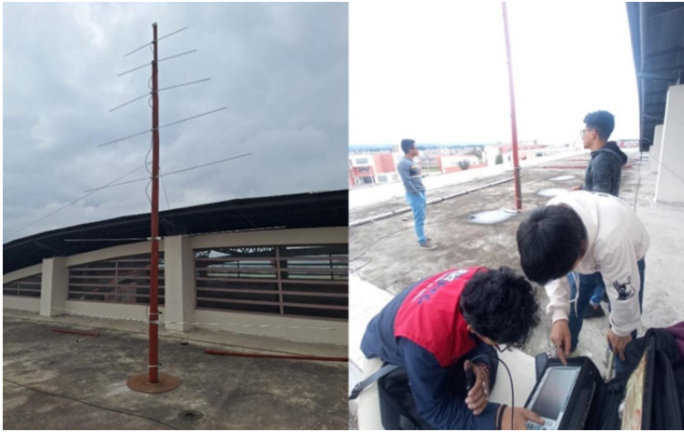
FIGURA 7. Instalación de la antena logarítmica y pruebas iniciales de funcionamiento.
